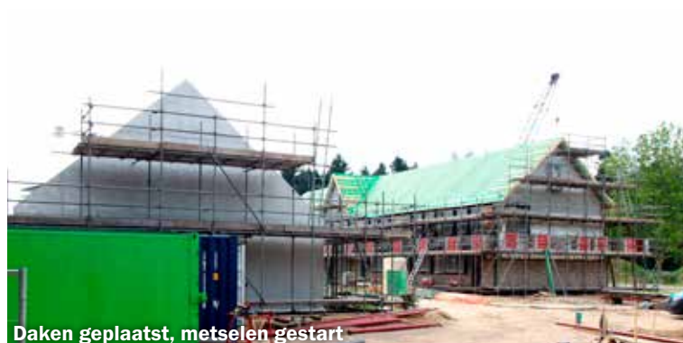
Daken geplaatst, metselen gestart
