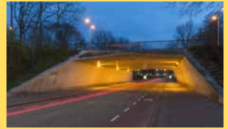
Tunnel onder Nieuwe Dukenburgseweg
