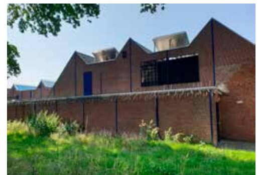
Ombouw voor de ventilatoren
