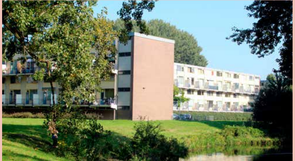
Het woonblok links op de voorgrond wordt gesloopt en vervangen door nieuwbouw
