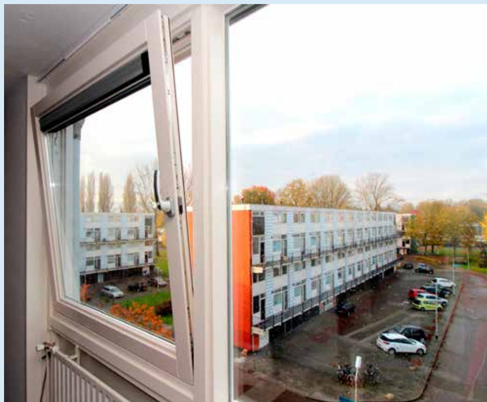
Het nieuwe draai-kiepraam waarvan er drie op de bovenverdieping geplaatst gaan worden
