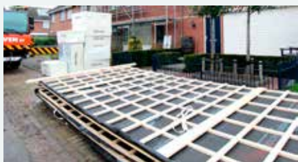
Een nieuw dak ligt klaar
