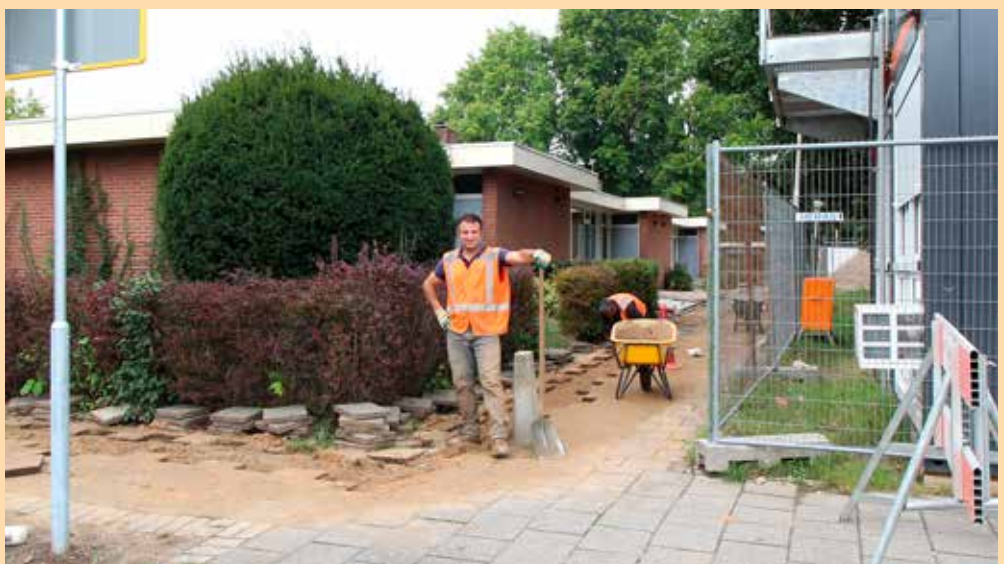
Goedgemutste werkers bij de aanleg van een glasvezelkabel in Meijhorst
