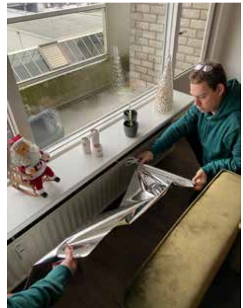
Plaatsen van radiatorfolie
