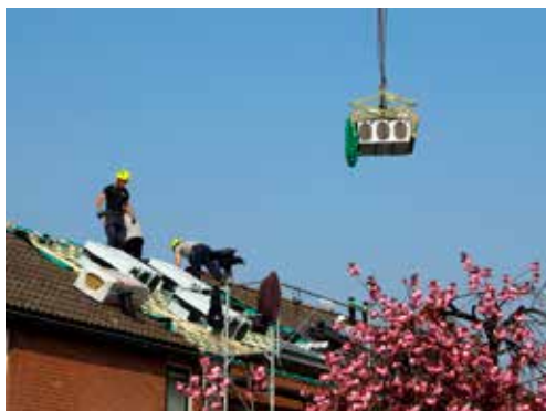
Nieuwe pannen worden het dak opgehesen
