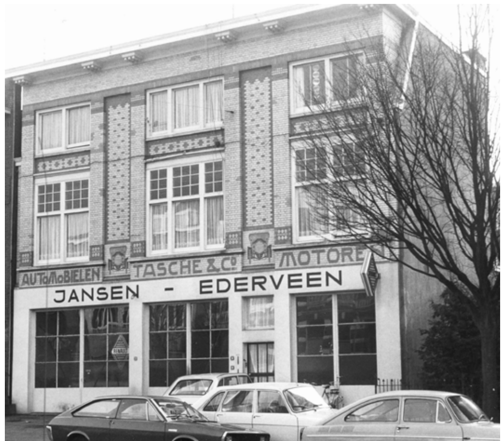
De garage aan de Gerard Noodtstraat in 1972 (Foto: Evert F. van der Grinten, collectie RAN)
