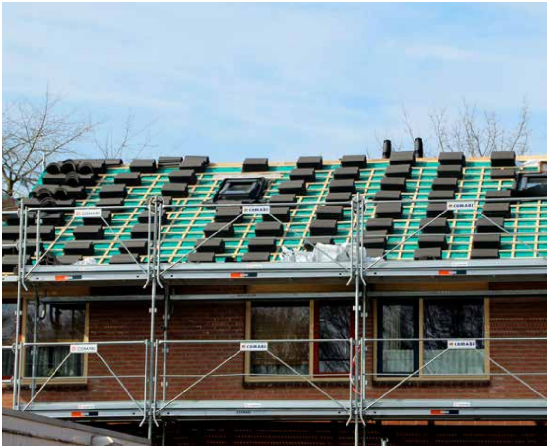
Nadat de panlatten zijn vernieuwd komen de pannen erop
