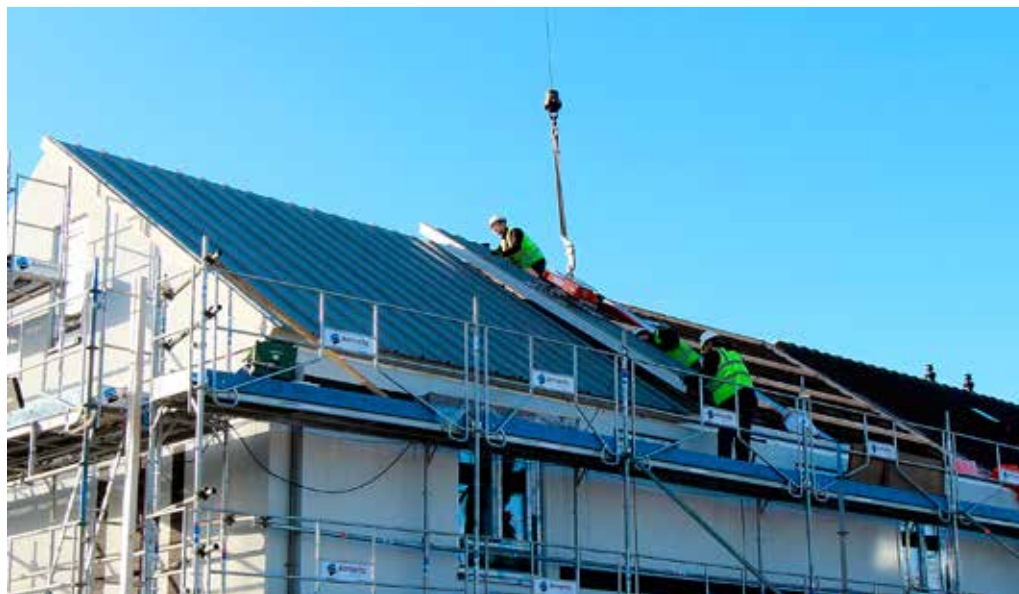
Dakdelen komen strak tegen elkaar. Meijhorst, 11 februari 2019
