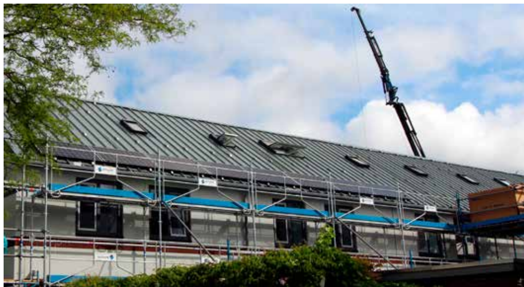
Nieuw dak vlak voor plaatsing zonnepanelen. Meijhorst, 9 mei 2019
