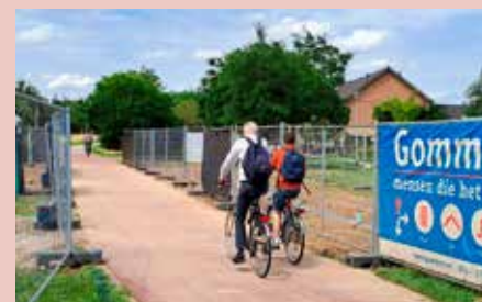
Het fietspad is weer open
